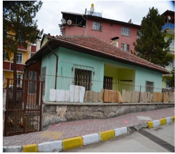
Eski Hizmet Binası
