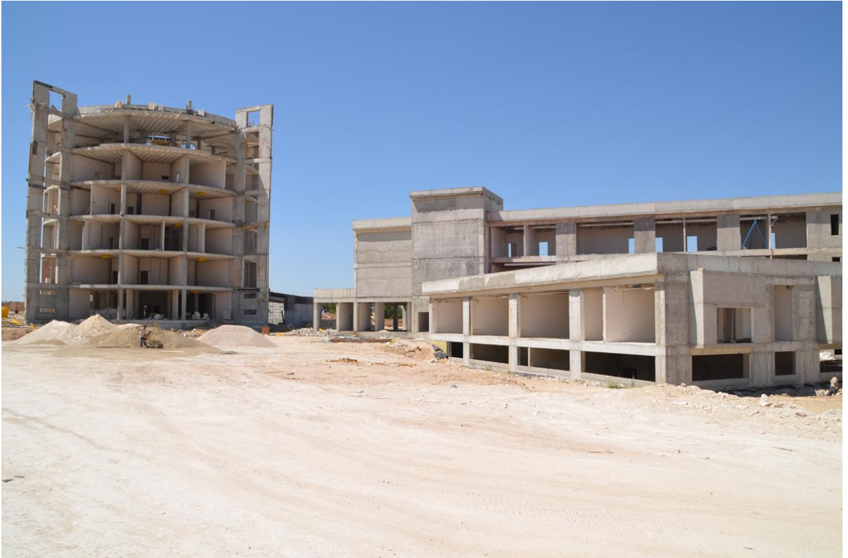
İstiklal Yerleşkesi Rektörlük Binası İnşaatı
