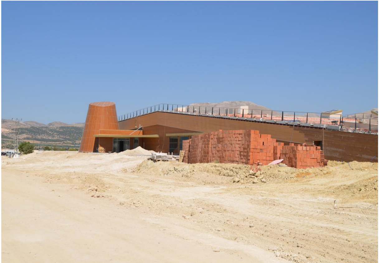
Spor Kompleksi İnşaatı
