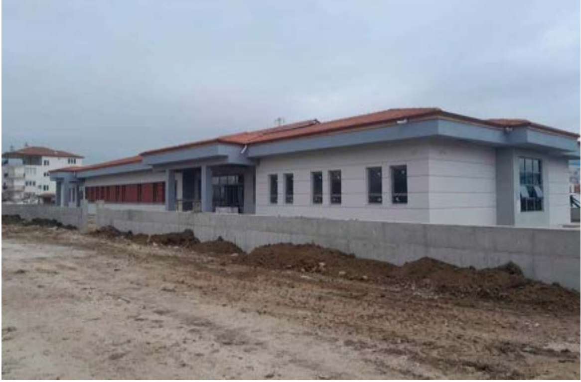
Burdur Bucak Barbaros ASM+112 ASH Binası Yapım İşi
