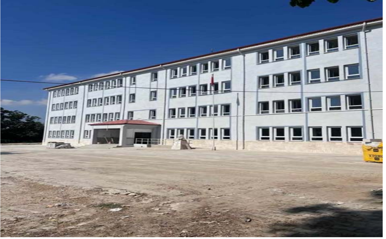
Burdur Ağlasun Şehit Bayram Yeşil ÇPAL Binası Deprem Güçlendirme Yapım İşi
