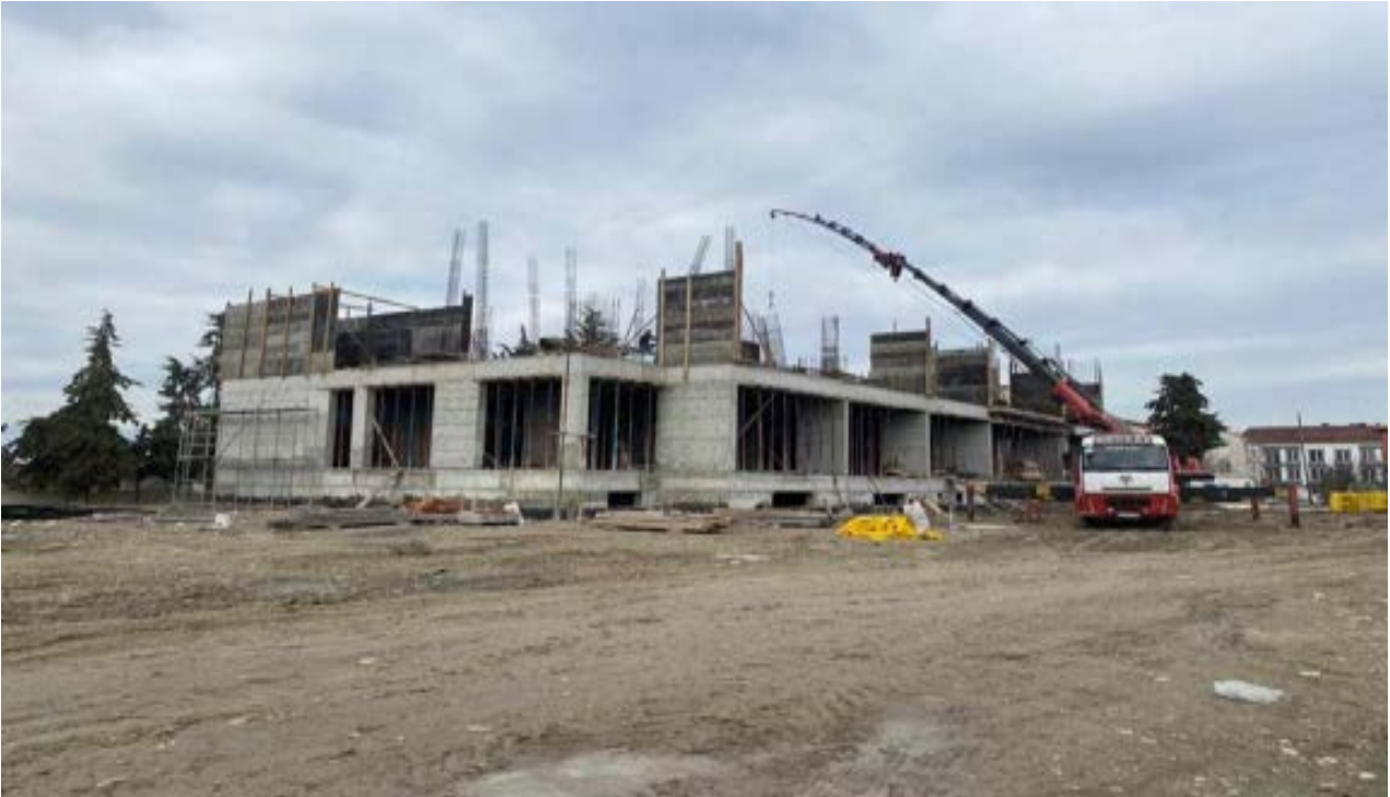
Burdur Merkez Vali Dr.Süleyman Oğuz 16 Derslikli İ.Ö.Okulu Yapım İŖi
