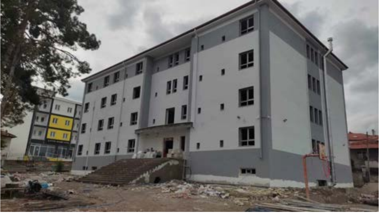
Burdur Gölhisar Atatürk İ.Ö.Okulu Binası Deprem Güçlendirme Yapım İşi
