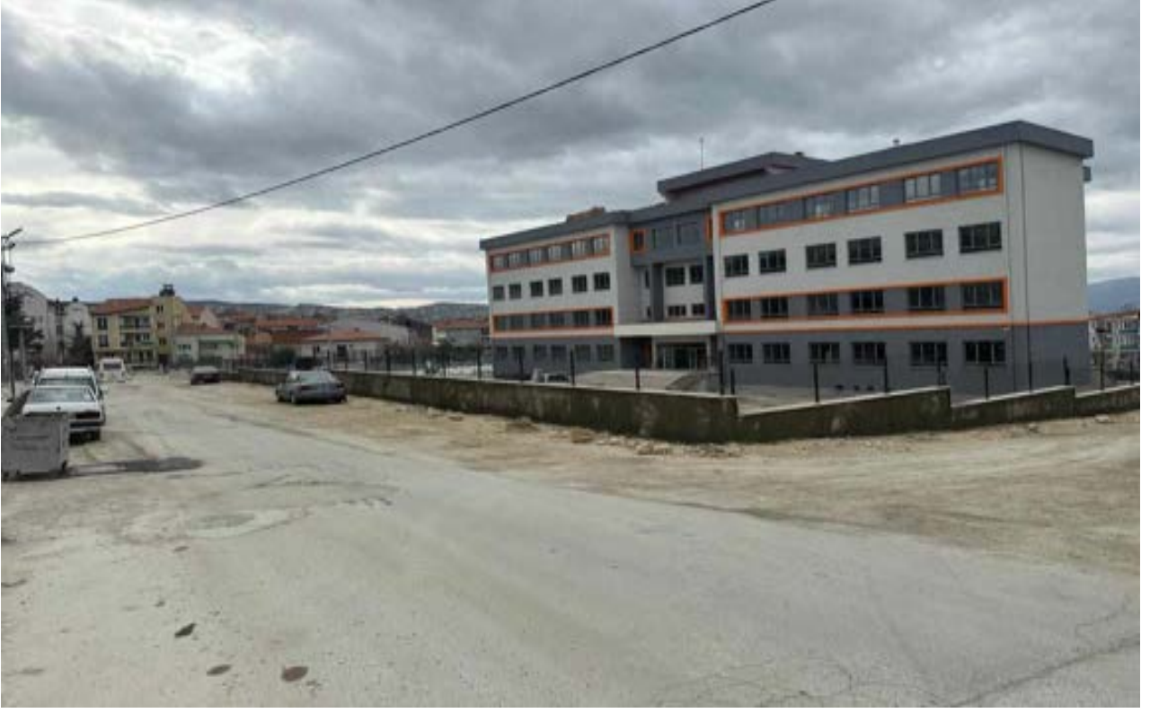
Burdur Merkez Kayışzade Osman Ortaokulu (24 Derslikli) Yapım İŖi
