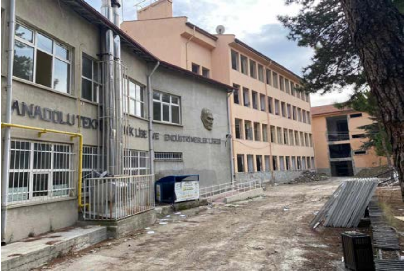
Burdur Merkez Mesleki Teknik Anadolu Lisesi Binası Deprem Güçlendirme Yapım İşi
