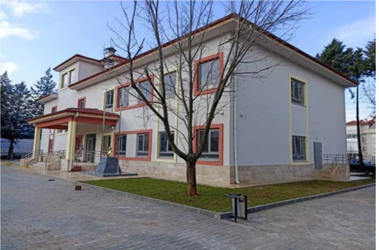
Burdur Bucak TOBB 6 Derslikli Anaokulu Yapım İşi
