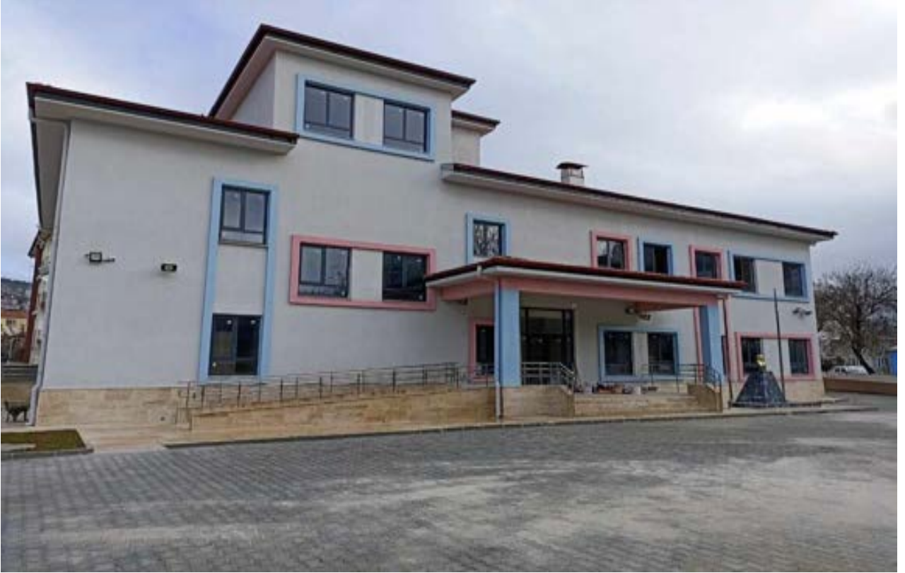
Burdur Bucak Ođuzhan (6 Derslikli) Anaokulu Yapım İŖi
