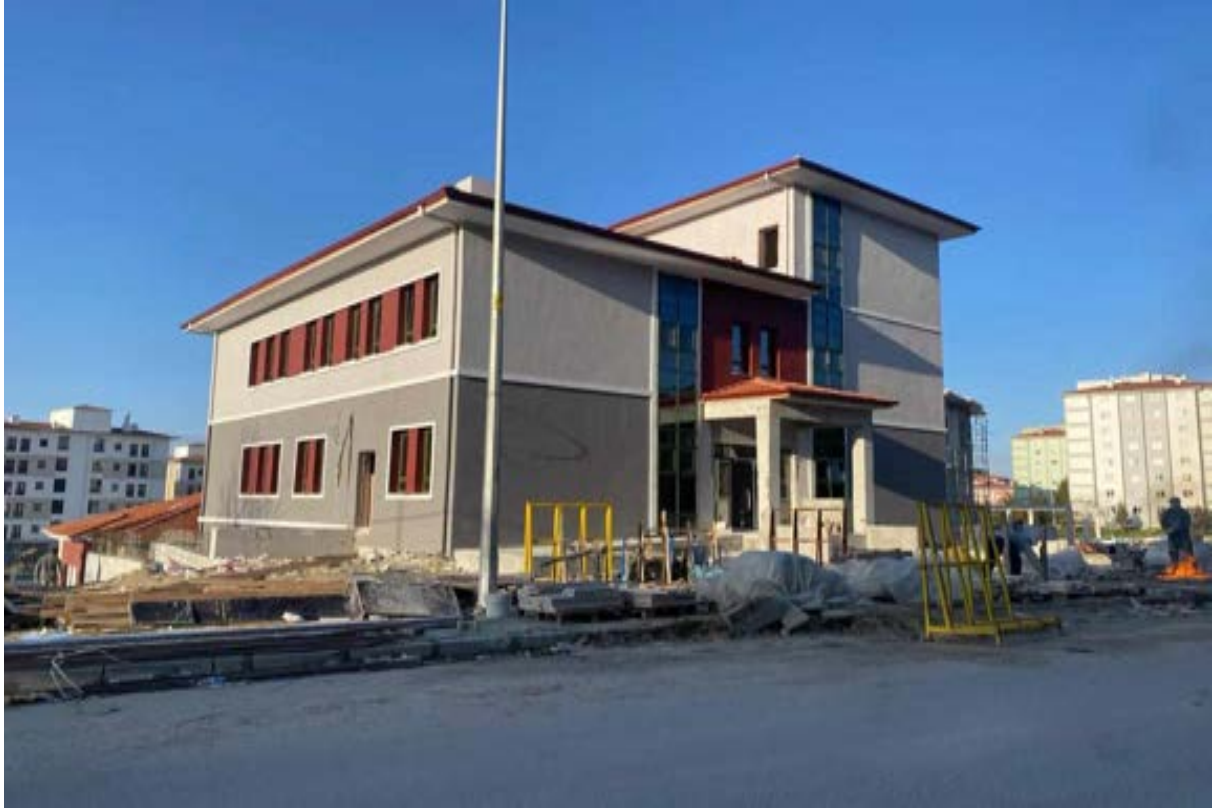
Burdur Merkez 4 Nolu TOKİ ASM+112+ ASH Binası Yapım İşi
