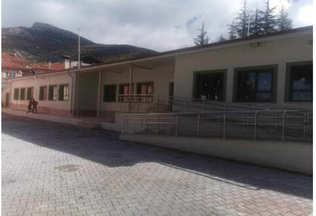
Burdur Altınyayla Merkez Anaokulu Deprem Gçlendirme Yapım İŐi
