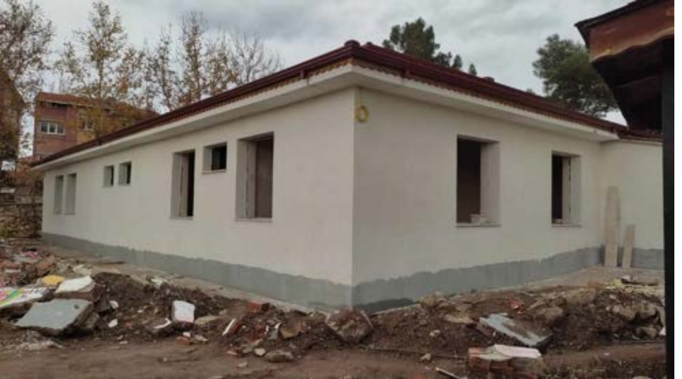
Burdur Çavdır Anaokulu Binası Deprem Güçlendirme Yapım İşi
