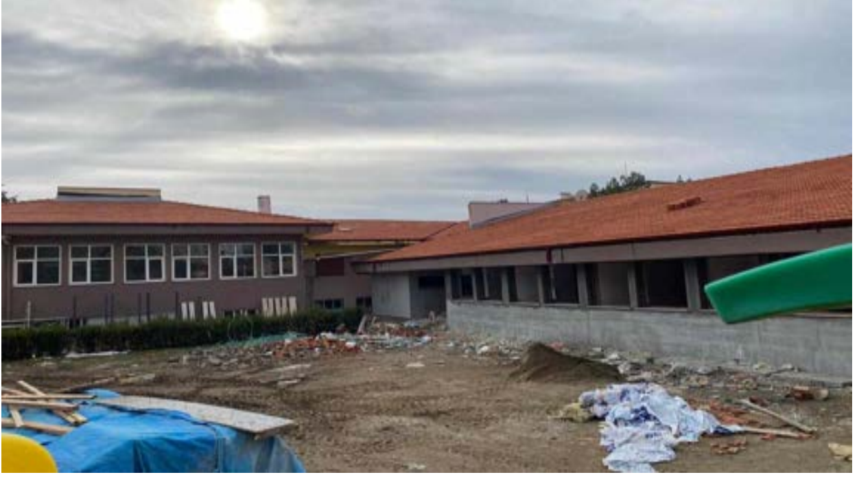
Burdur Merkez 75.Yıl Anaokulu Deprem Gçlendirme Yapım İŐi
