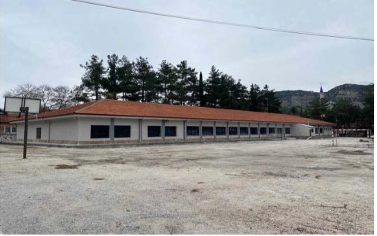
Burdur Merkez İstiklal Ortaokulu Deprem Güçlendirme Yapım İşi
