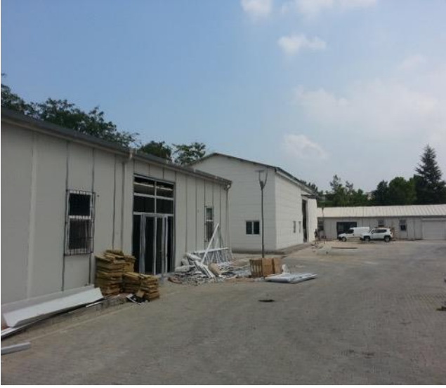
Şekil 2. İnşaat Mühendisliği Laboratuvarı
