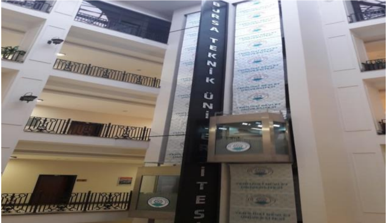
Şekil 8. Mimar Sinan Yerleşkesi Asansör Arkası İsimlik İmalatı ve Montajı İşi
