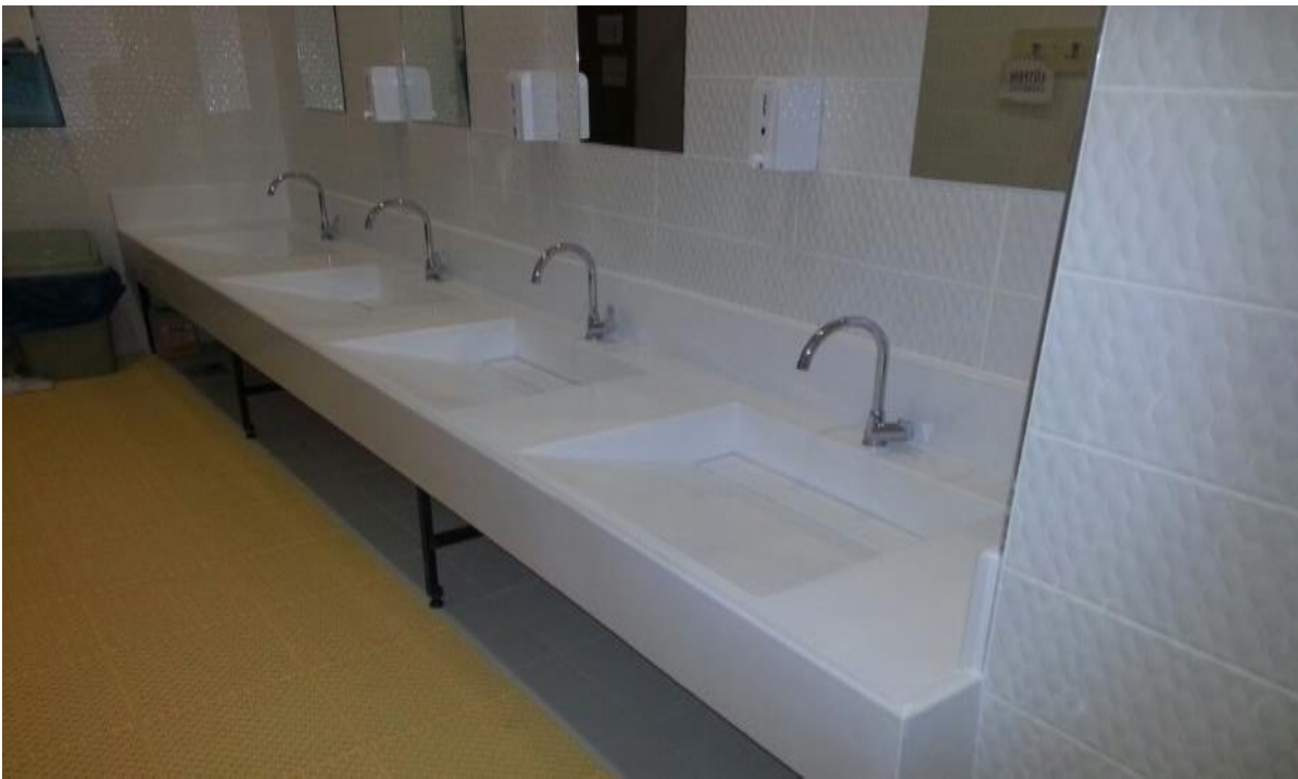
Şekil 10. Yıldırım Yerleşkesi Sosyal Yapı Tadilat Yapılması İşi
