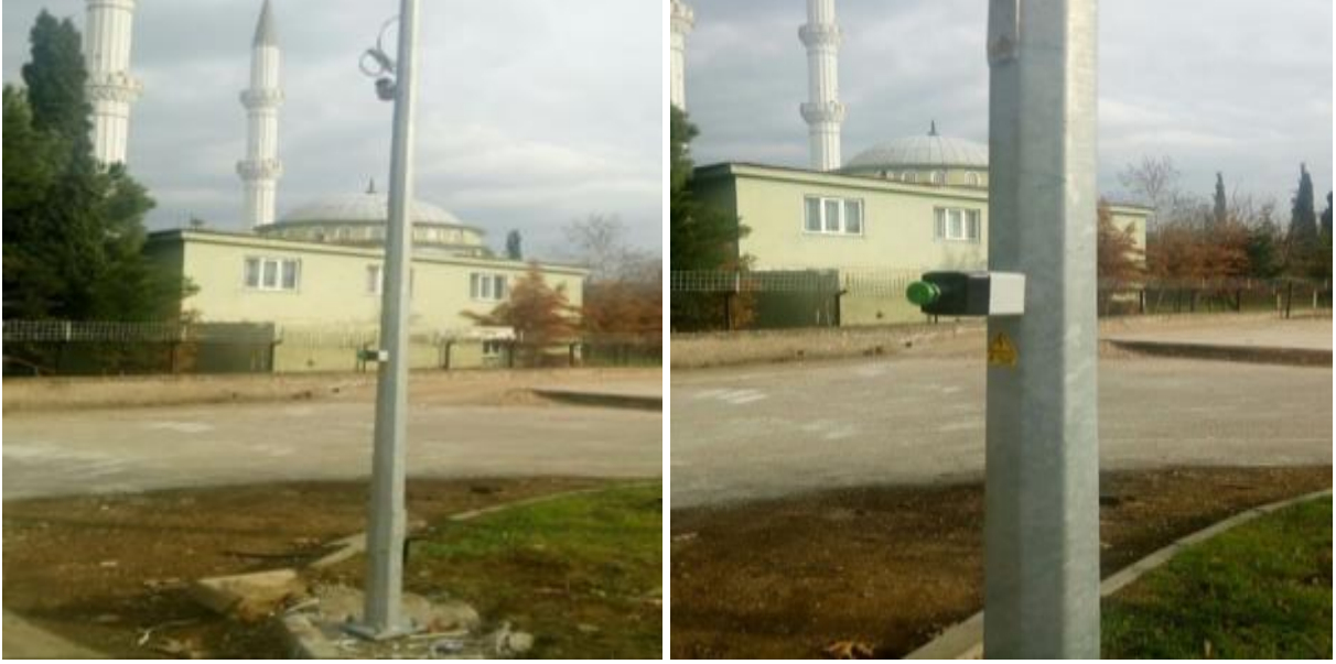
Şekil 4. Mimar Sinan Yerleşkesi Çevre Aydınlatma İmalatları Yapım İşi
