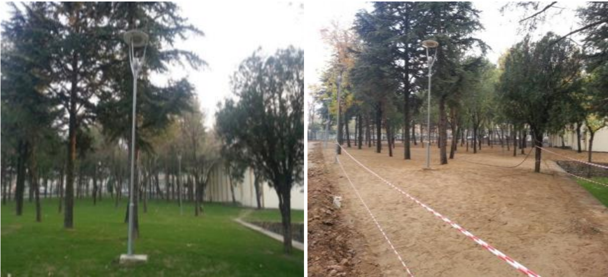
Şekil 3. Yıldırım ve Mimar Sinan Yerleşkesi Bitkisel Toprak Serilmesi ve Çevre Düzenlemesi İşi
