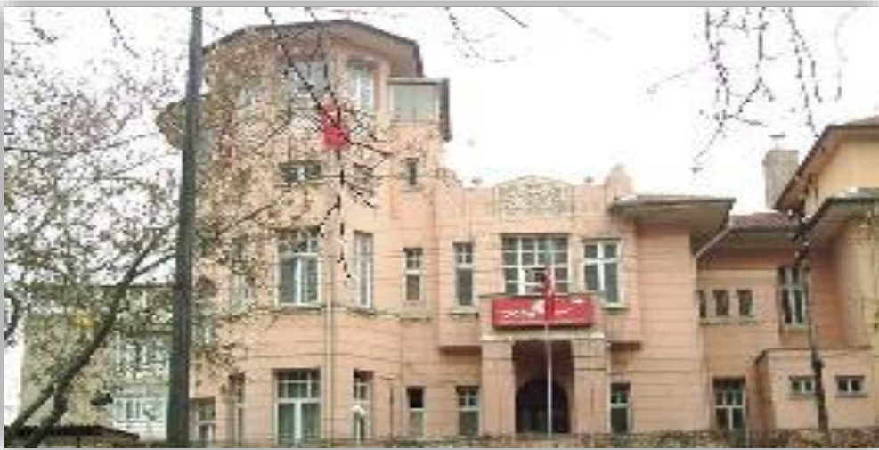
Demirtepe Ek Hizmet Binası
