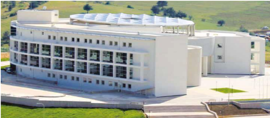
Resim 1- Kastamonu Üniversitesi Rektörlüğü Görünüm
