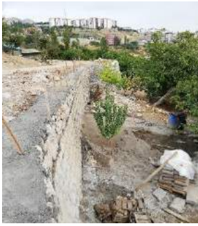
Gühuzuk yol genişletilmesi ve destek duvar yapımı.
