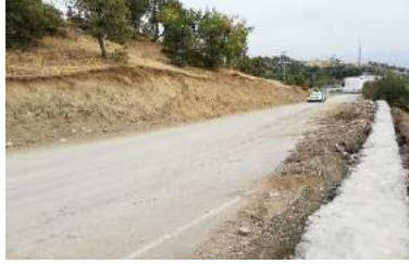
Müşüle yol genişletilmesi ve destek duvar yapımı.
