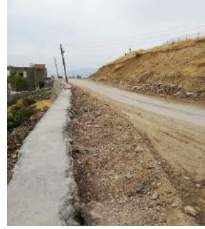
Gühuzuk yol genişletilmesi ve destek duvar yapımı.
