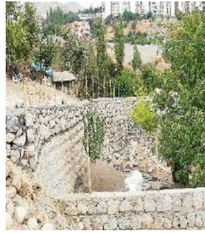
Gühuzuk yol genişletilmesi ve destek duvar yapımı.
