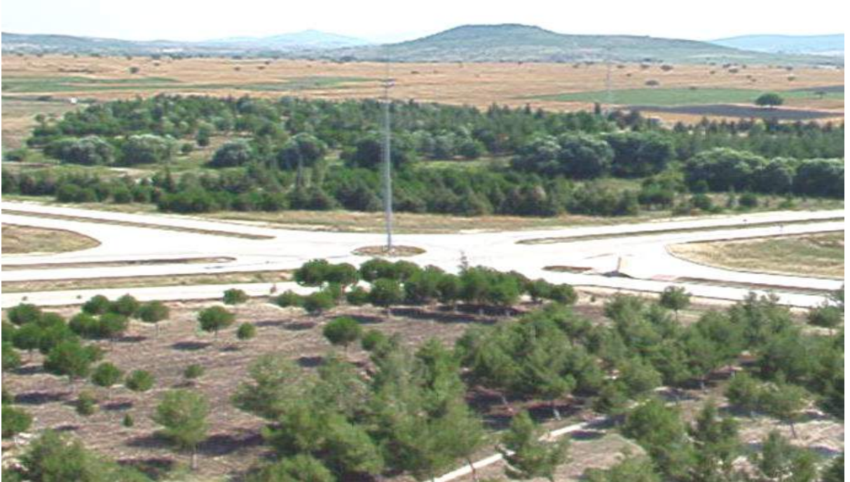
Kampüs Alt Yapı İnşaatı
