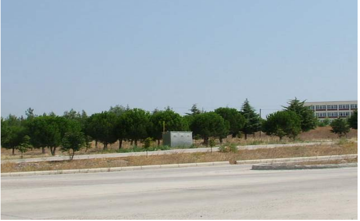
Doğal Gaz Dağıtım İstasyonu
