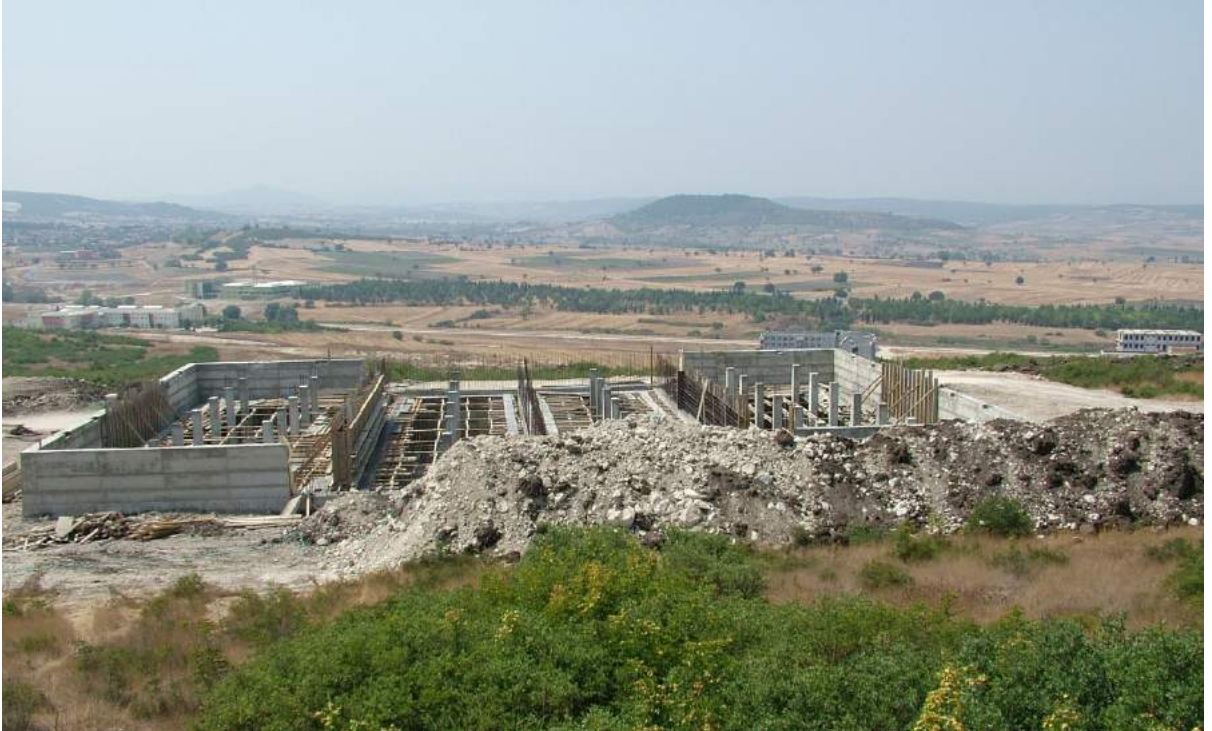
Su Deposu İnşaatı
