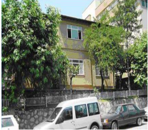
Eski Hizmet Binası
