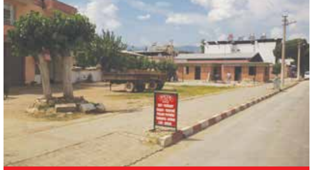
➤ Çapahasan Muhtarlık Önü (Yapım aşaması)
