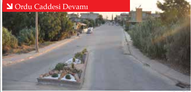
➤ Yolda Parke ve Bordür Çalışmaları
