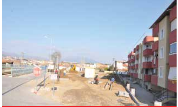
➤ Necmettin Erbakan Parkı (Yapım hali)
