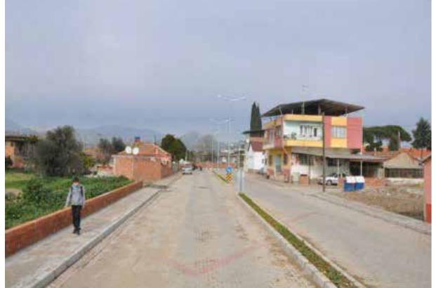
➤ Alparslan Türkeş Bulv. Refüj yapım aşaması
