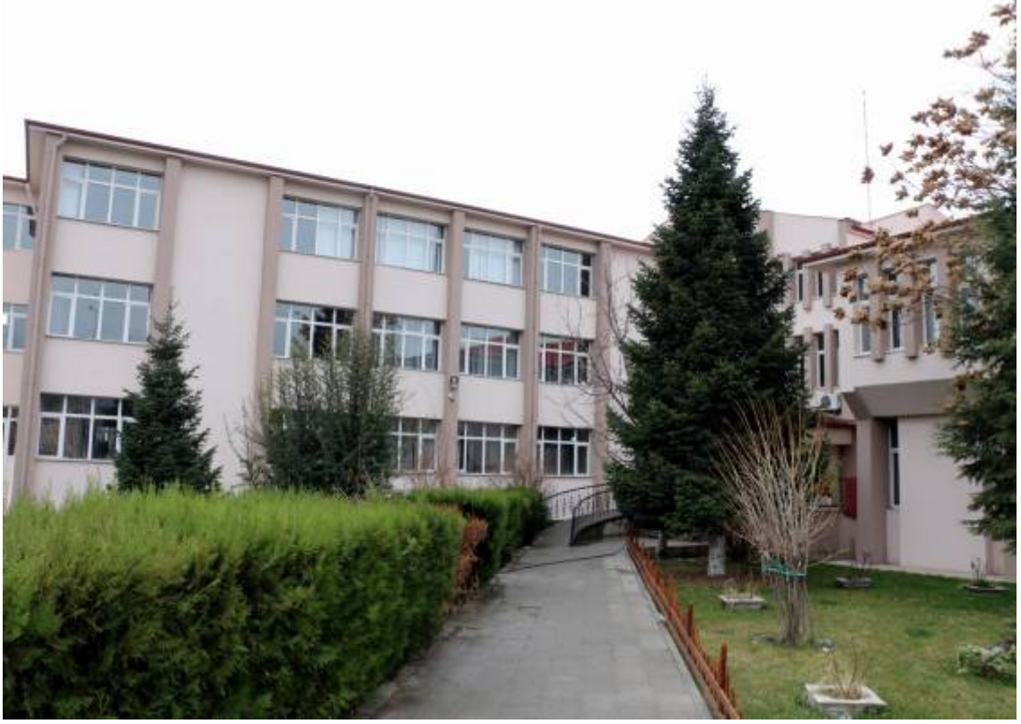
İl Özel İdaresi Hizmet Binası
