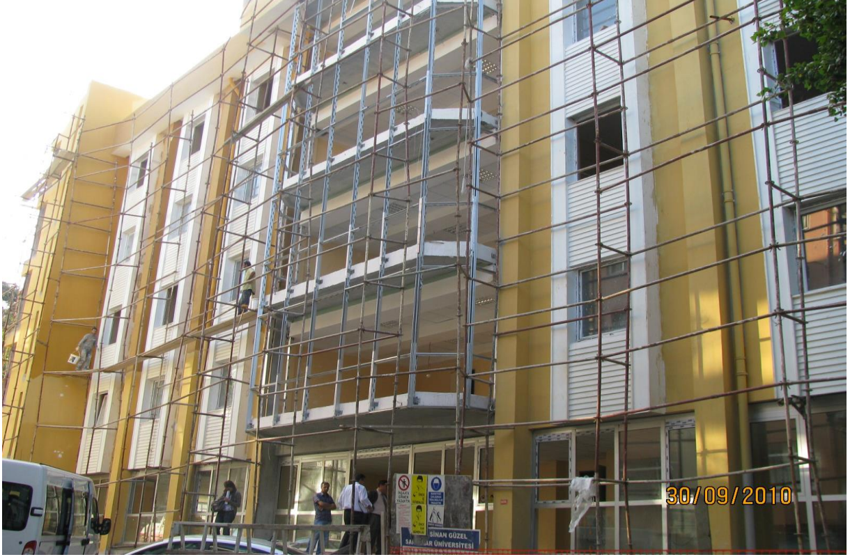
Ortaköy yurt inşaatı dış cephe görünüşü
