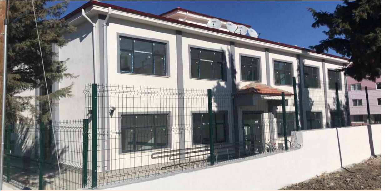
BURDUR MERKEZ 9 NOLU 6 HEKİMLİ AİLE SAĞLIK MERKEZİ VE 112 ACİL SAĞLIK HİZMETLERİ İSTASYONU HİZMET BİNASI İNŞAATI
