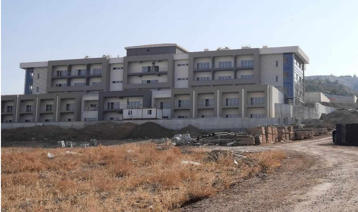
Burdur Merkez (96 Kişilik) huzur Evi Yapım İnşaatımız
