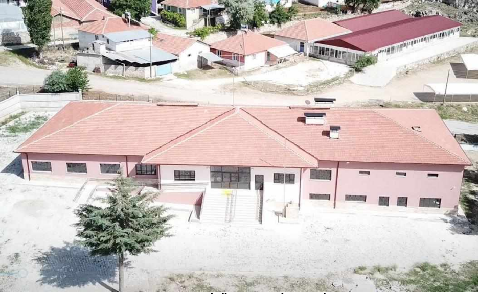
Burdur Merkez Çatağıl İ.Ö.Okulu İkmal İnşaatı
