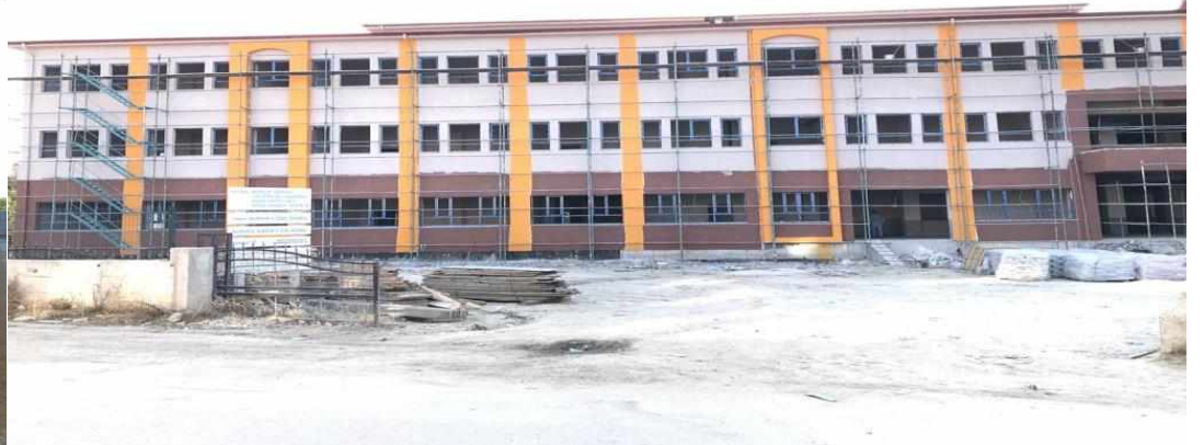
Burdur Merkez 16 Derslik Anadolu İmam Hatip Lisesi İkmal İnşaatı
