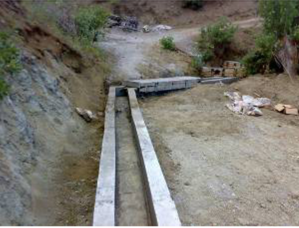
Sulamasuyu Kanalet Çalışmasının Bitmiş Hali
