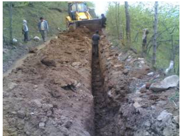
İçmesuyu Kanallarında Makineli Kazı Çalışması
