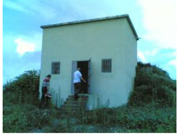
Yapımı Tamamlanmış İçmesuyu Deposu
