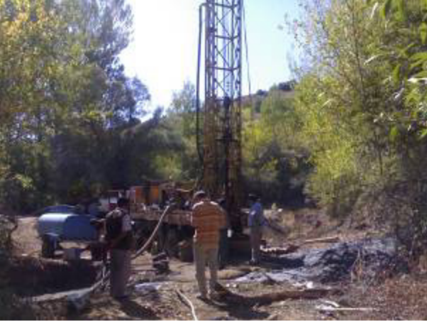
İçmesuyu Sondaj Çalışmaları
