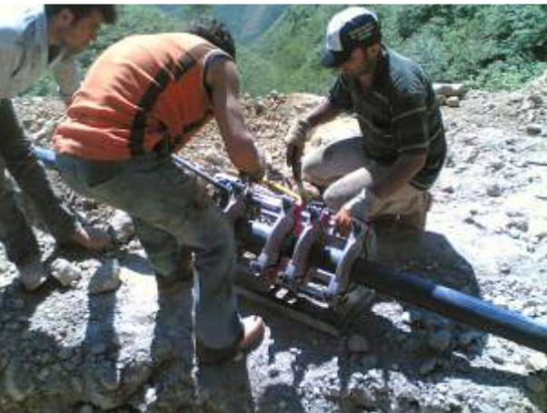
İçmesuyu Borularında Alın Kaynağı Yapılması
