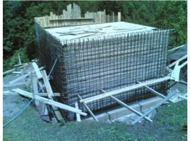
İçmesuyu Deposu Demir Donatısı
