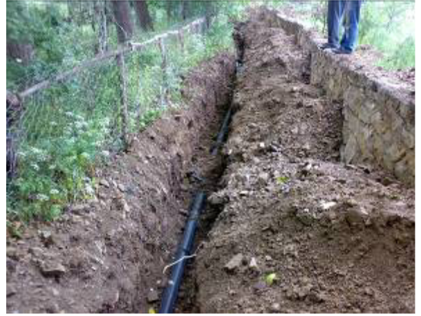
İçmesuyu Borusu Döşeme Çalışmaları
