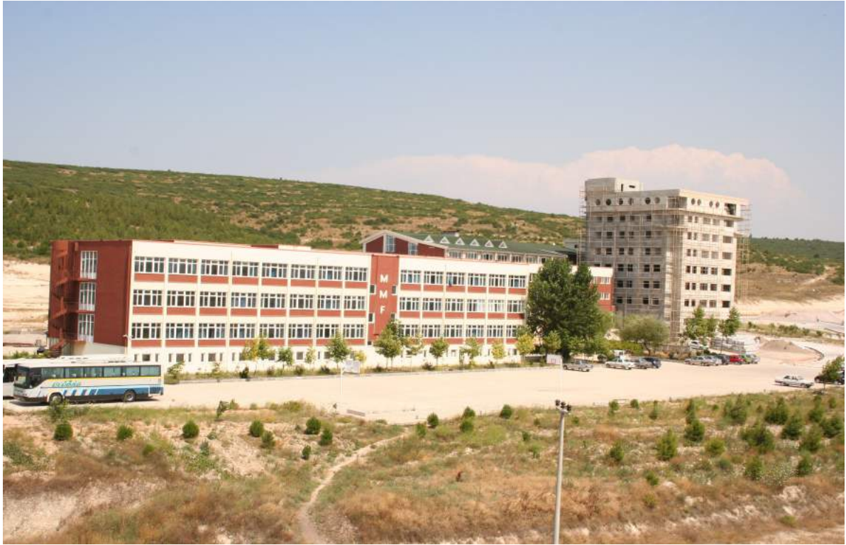
Mühendislik - Mimarlık Fakültesi İnşaatı
