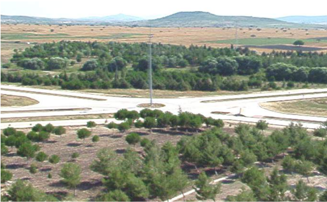
Kampus Alt Yapı İnşaatı
