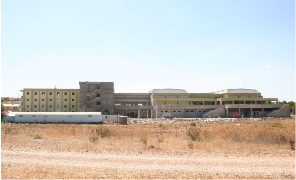
Turizm İşletmeciliği ve Otelcilik Yüksekokulu – Uygulama Oteli İnşaatı
