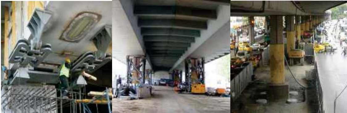
Sismik Takviye Çalışmaları
