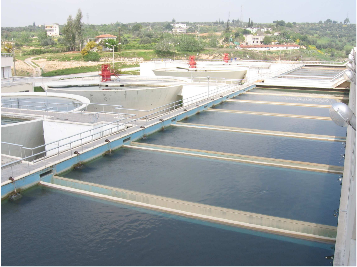
Şekil 1. Berdan İçmesuyu Arıtma Tesisi
